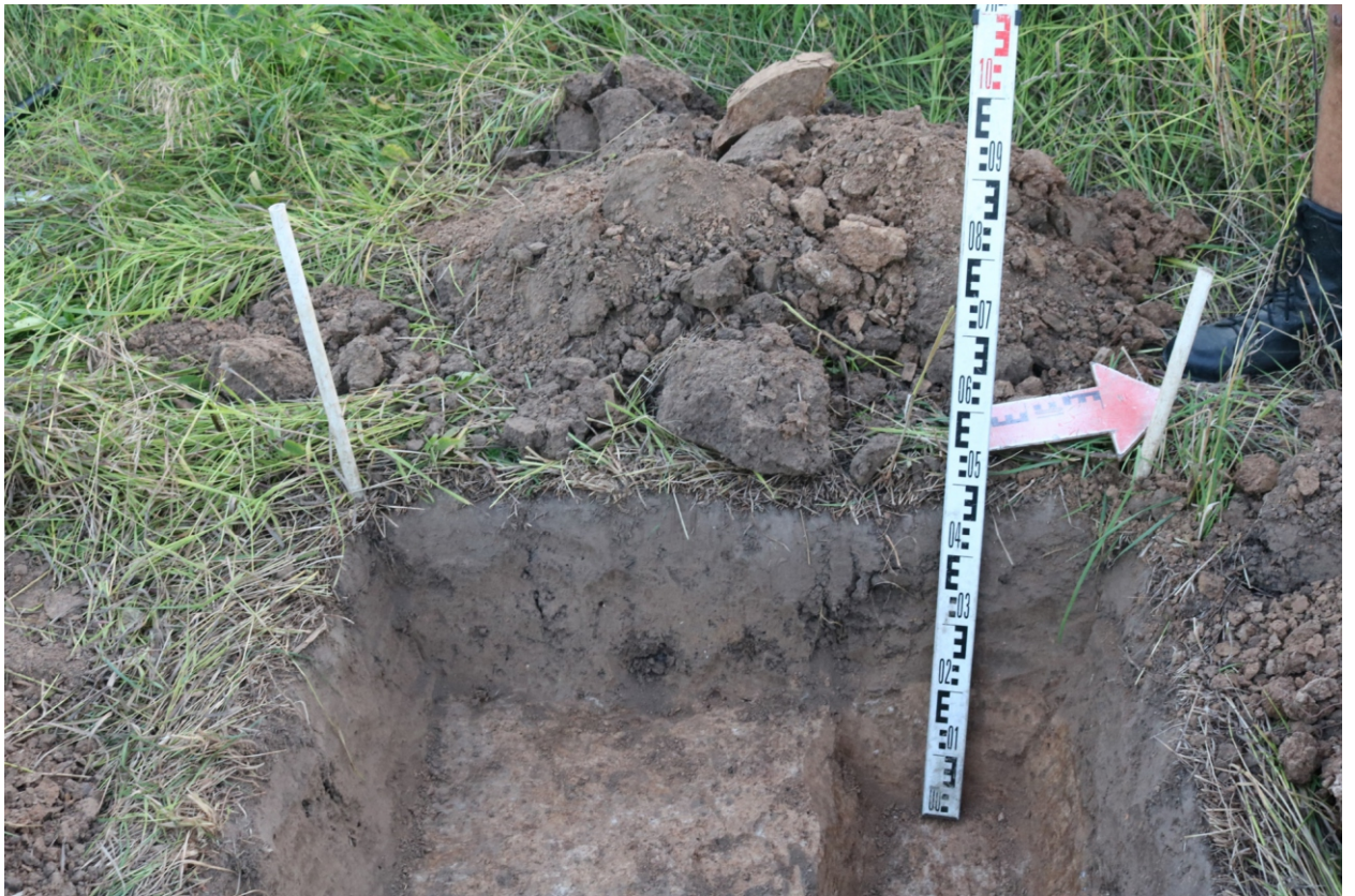
Рис. 28. Археологическое обследование участка по объекту: «Уличные газопроводы дер. Внуково Бабынинского района Калужской области». 2023 г. Шурф 2. Западный борт. Вид с В.
